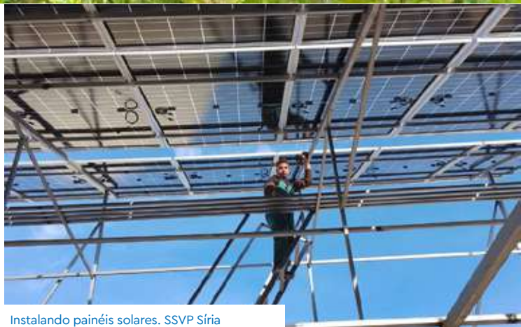
Instalando painéis solares. SSVP Síria
